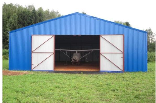
Ангары мобильны: ограждающие конструкции и каркас можно разбирать и перевозить.
